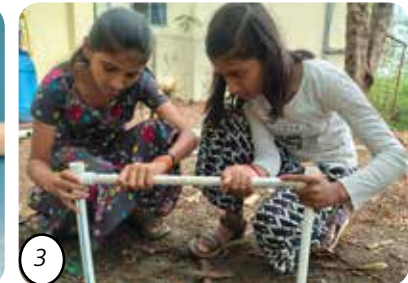
छोटे आकार के पाइप को काटकर जोड़ा (जॉइंट) गया।
